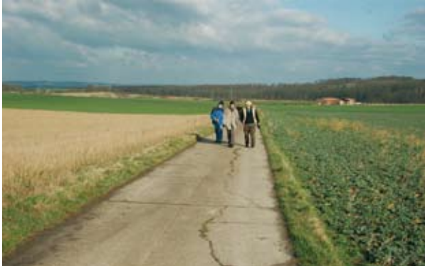
Abb. 1: Asphaltierter Feldweg beim Quellenhof
